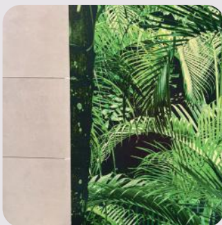
Okładzina tapetowa zadrukowana na odnawianej glazurze pokryta lakierem epoksydowym EPIMAL LAQ
