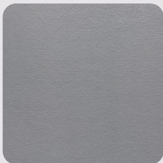
Okładzina tapetowa pokryta jednobarwną farbą epoksydową EPIMAL 200
